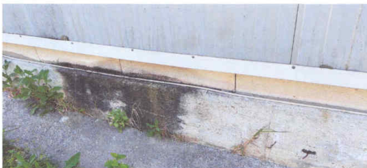
Вижда се част от бетонната настилка, оформяща нисък цокъл по периферията.
