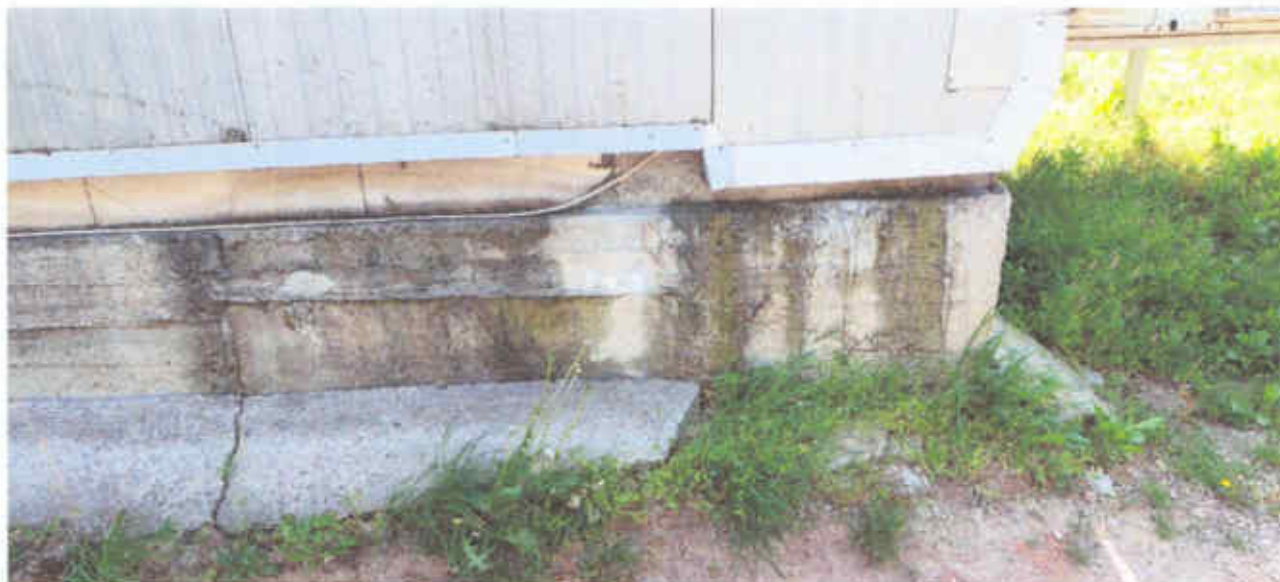
Вижда се част от бетонната настилка, оформяща нисък цокъл по периферията.
